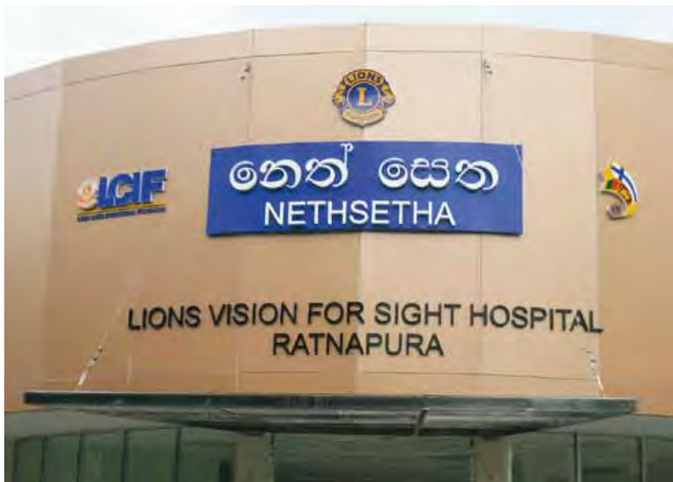
Die fast fertige Eingangsfassade der Klinik. Das Logo des finnischen Außenministeriums „UM“ fehlt noch. Foto: PID Asoka Gunasekera
