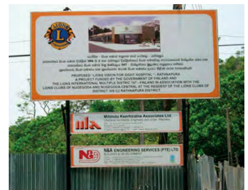
Bis zur Einweihung der Klinik gibt es noch genug zu tun. Ansicht von der Bautafel.
